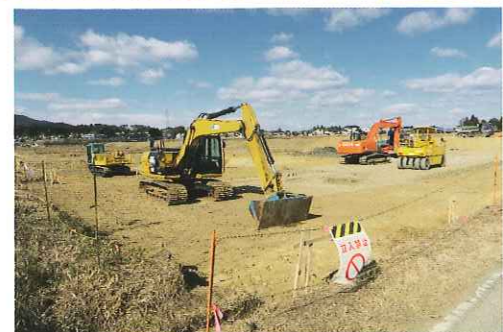
ただいま工事中(長磯中原地区)
